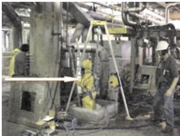
**Foto 12 C:** Operadores entrando no tanque para efetuar limpeza e inspeção em ambiente confinado (item 2.3.2) Detalhe: utilização de tripé para acesso e resgate
